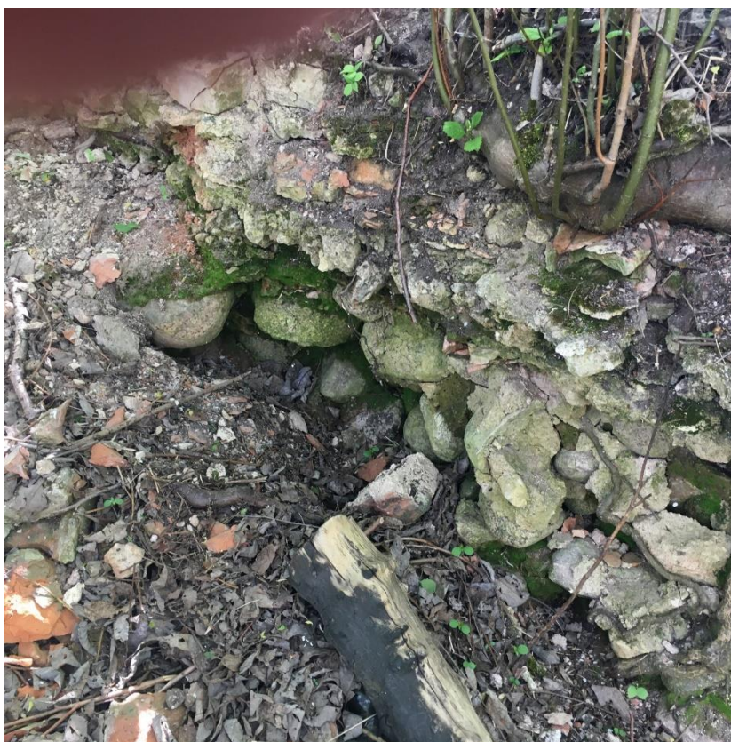
Фундамент храма Троицкого монастыря (Из фотоархива Глотова В. А.)
